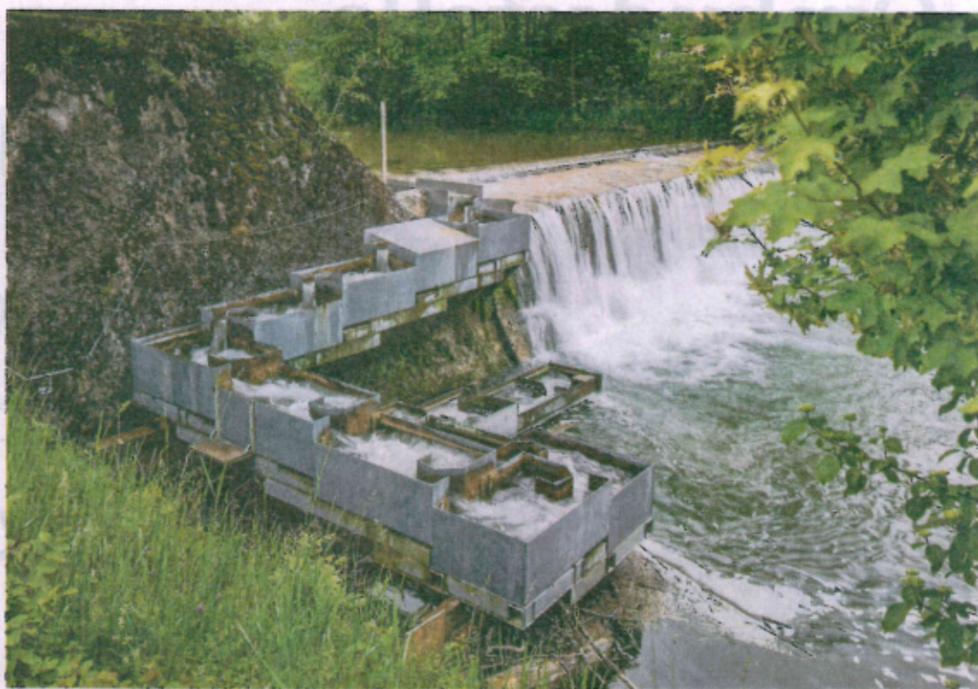
Modulare Fischtreppe Steffstep in Kollbrunn: Sie wurde gestern an den Kanton übergeben.
