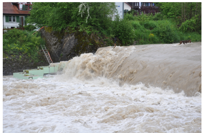
Abbildung 15: Hochwasser Mai 2016 mit 53 \text{ m}^3/\text{s}
