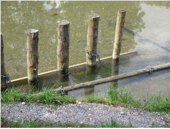
Abbildung 13: Hochwasserschutz vor dem Einlauf der Steffstep
