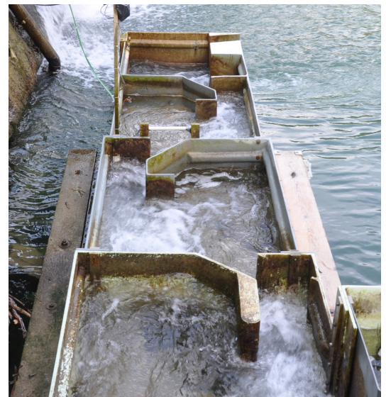
Abbildung 12: Einstieg neu (Becken 13, 14 und verlängertes Becken 15)
