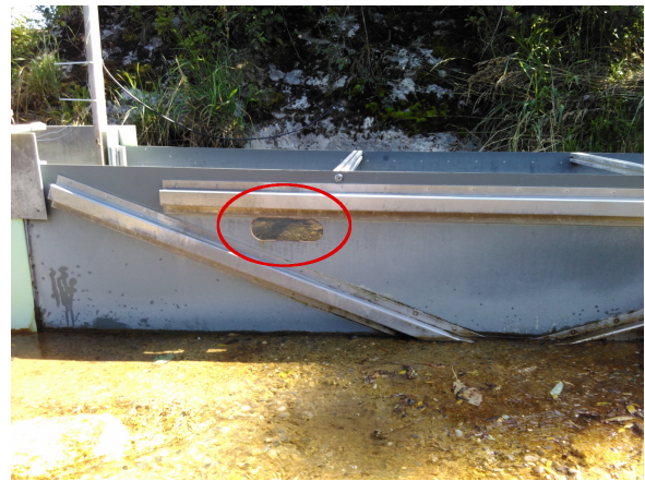
Abbildung 14: Überlaufschlitz am Einlauf der Steffstep (Becken 1)
