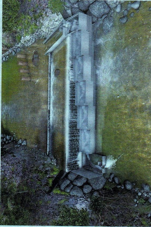
Die Fischtreppe im Baukastensystem. Der Ausgang wird durch einen Buhnenstein und stabile Holzpfähle vor Verunreinigung geschützt. Bild: ebs
