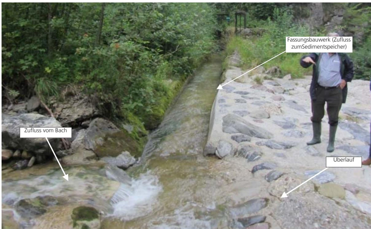
**Abb. 2.2:** Ansicht des Fassungsbauwerkes am Spreitenbach in Richtung Sedimentbecken. Das Wasser fließt über die Rinne in das Sedimentbecken.
