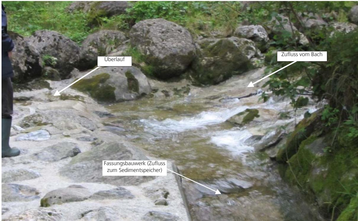
**Abb. 2.2:** Ansicht des Fassungsbauwerkes am Spreitenbach entgegen der Fließrichtung.
