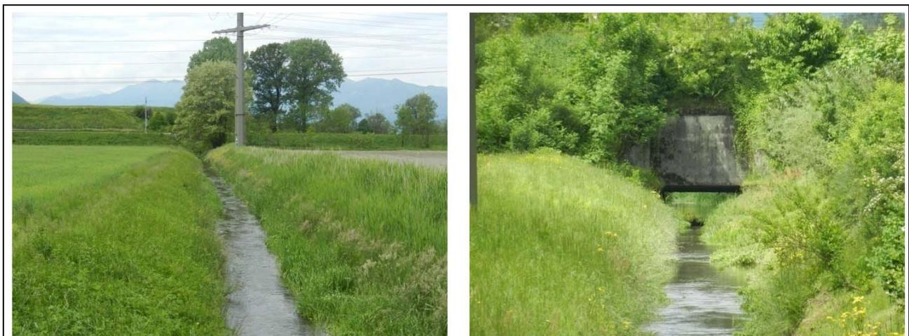
**Figura 3.9** – Il canale principale in sponda destra, ecomorfologicamente fortemente compromesso, è prioritario. Le misure (allargamento della sezione, strutturazione dell'alveo e delle rive) potranno essere verosimilmente intraprese entro il 2023 (CCFT, 2014).
