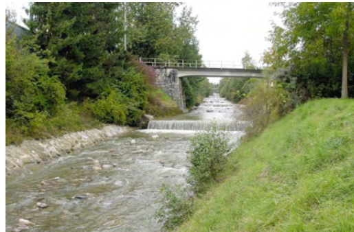
Abbildung 2.12: Trème: Querbauwerke zur Sohlenstabilisierung, September 2001 (Foto: L. Hunzinger, Schälchli, Abegg + Hunzinger).
