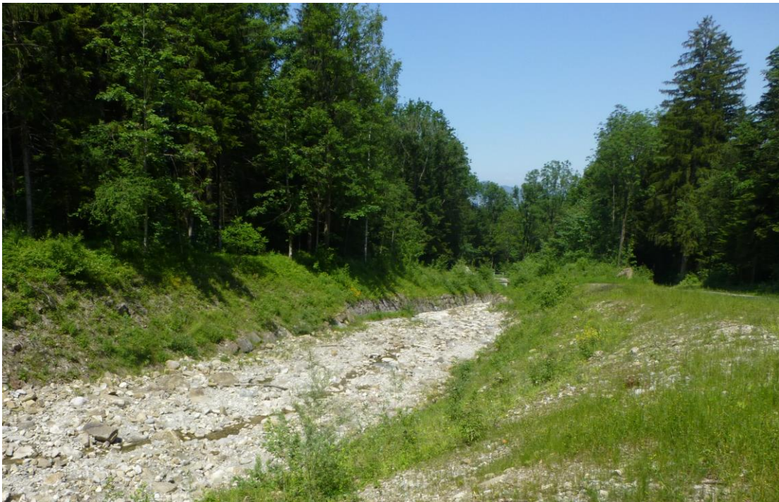
Abbildung 11: Dürrenbach unterhalb des Holzrechens mit Übergang von der neu erstellten Sohlensicherung (links) in die 100-jährige gepflästerte Rinne. (5.6.2015)
