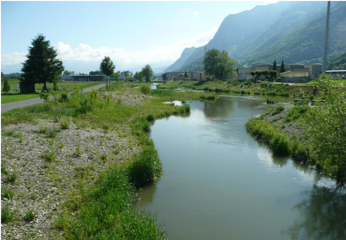
Abbildung 17: Rheintaler Binnenkanal bei Rüthi: Ausbau im Rahmen des Hochwasserschutzprojektes "Rheintaler Binnenkanal - Hochwasserschutz und Ökologie im Einklang" mit Aufweitung. Die Gestaltung des Gewässerbettes musste beim Ausbau erstellt werden, da Hochwasser keine genügende Kraft entwickeln um Ufer und Sohle zu verändern. Eine natürliche Gewässerdynamik ist nicht vorhanden. (4.6.2010)
