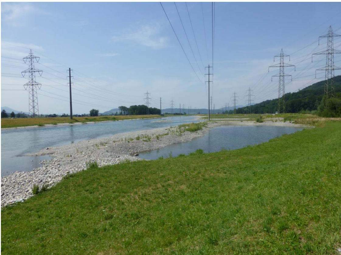
Abbildung 35: Aufweitung Hänggelgiessen, Blick flussabwärts (6.8.2013)
