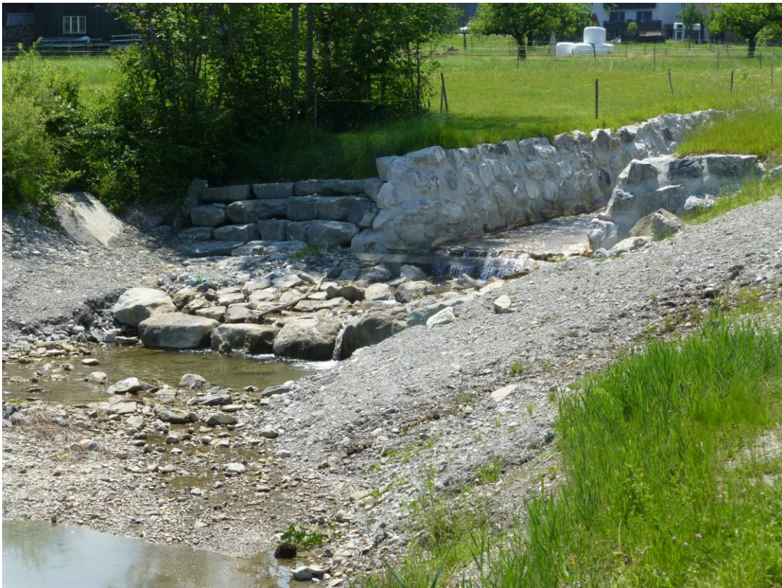
Abbildung 12: Einlaufbereich der gepflästerten Rinne in den Geschiebesammler. (5.6.2015)
