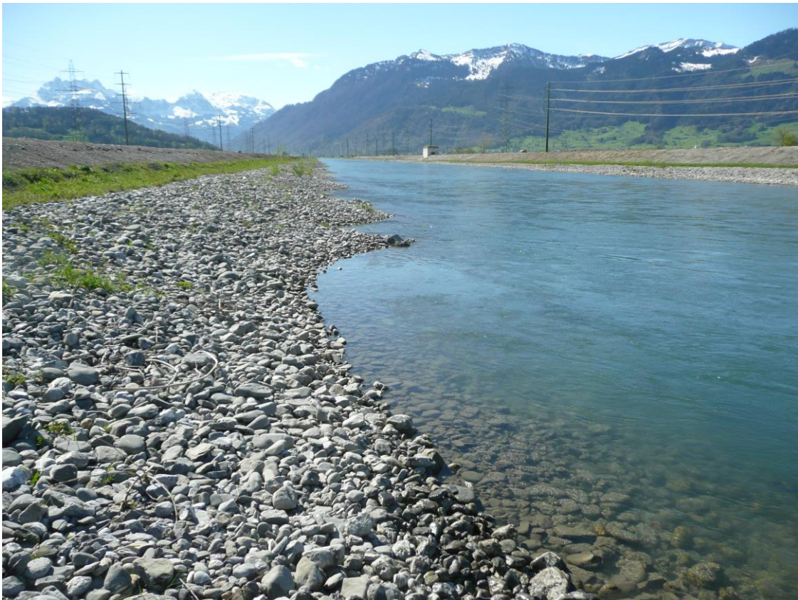
Abbildung 34: Linthkanal: neu erstelltes Flachufer mit Kiesschüttung (26.4.201)
