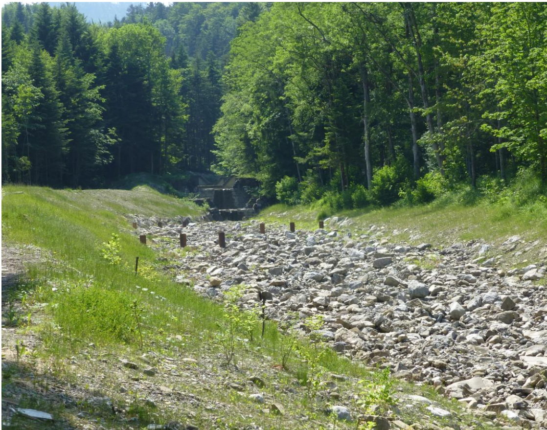
Abbildung 10: Im Dürrenbach neu erstellter Grobholzrechen. Im Hintergrund ist der unterste Teil der Sperrentreppe zu sehen. (5.6.2015)
