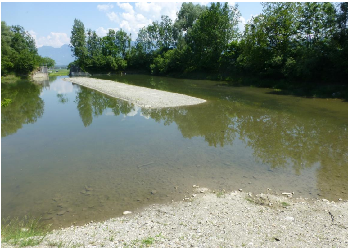
Abbildung 13: Geschiebesammler am Dürrenbach. Im geleerten Sammler wurde eine Berme stehen gelassen, damit der schwere Bagger bei der nächsten Entleerung eine stabile Fahrpiste vorfindet. (5.6.2015)
