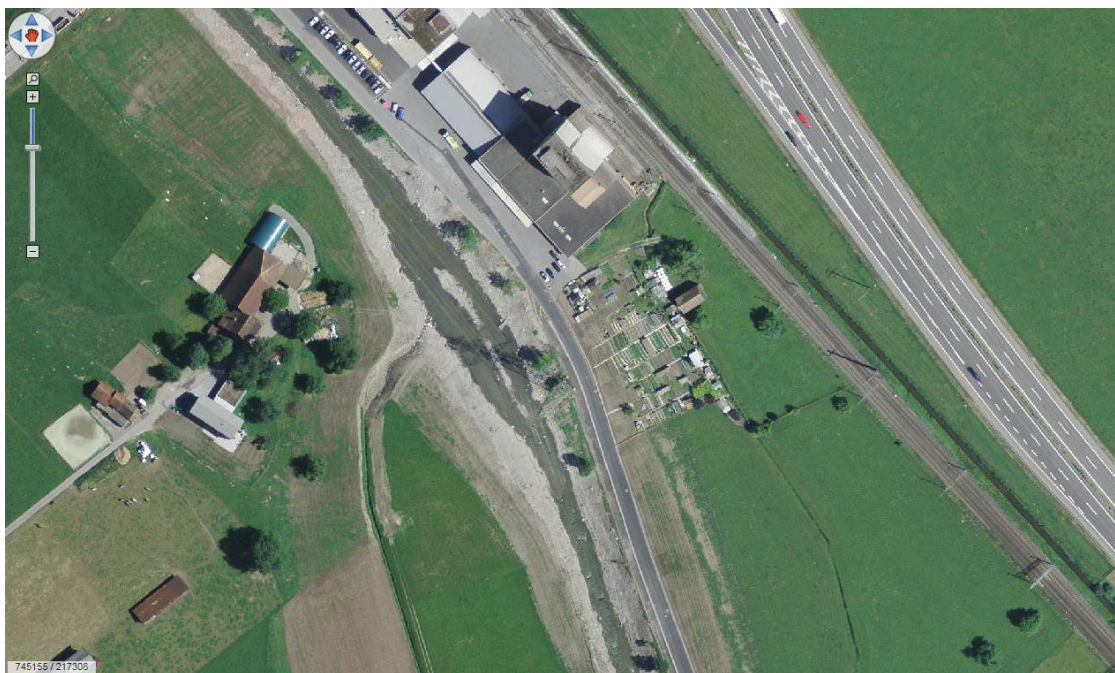
Abbildung 25: Aufweitung Bünteriet / Unterdorf Flums an der Seez. (geoportal.ch)
