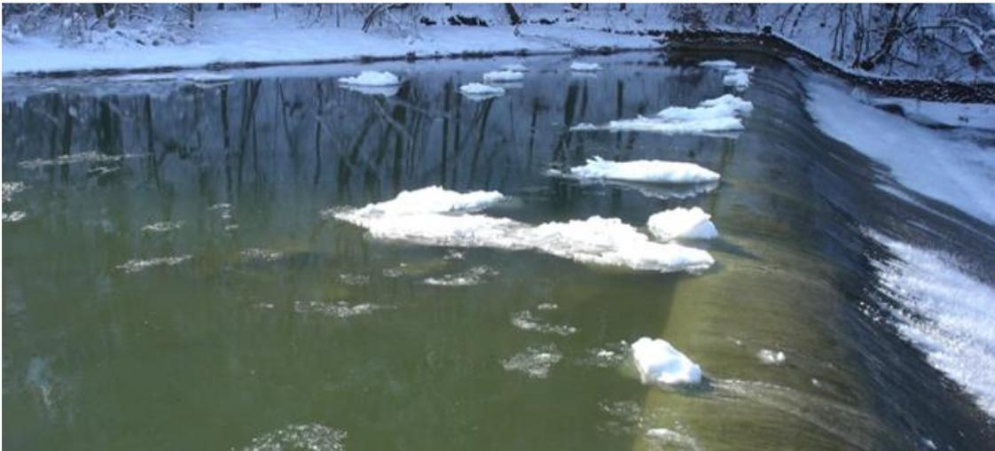
Abbildung 163: Stauwehr Erlenholz an der Sitter. Während des Schwalls fließt das im KW nicht nutzbare Überwasser über das Wehr ab.
