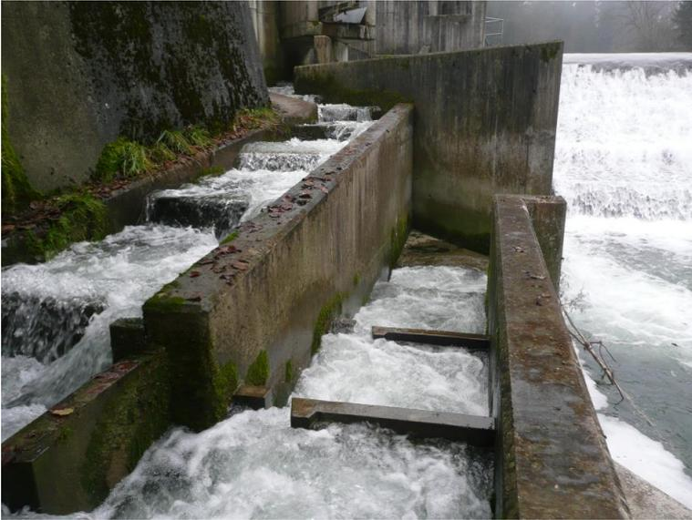
Abbildung 39: Gleiche Anlage wie Abbildung 38, mit zu hoher Dotierwassermenge, zu grosser Energieeintrag in Fischaufstiegshilfe
