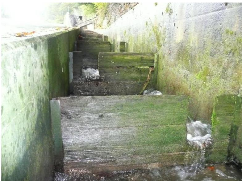
Abbildung 36: Beckenpass mit morschen und undichten Zwischenbrettern und ungenügender Wasserführung
