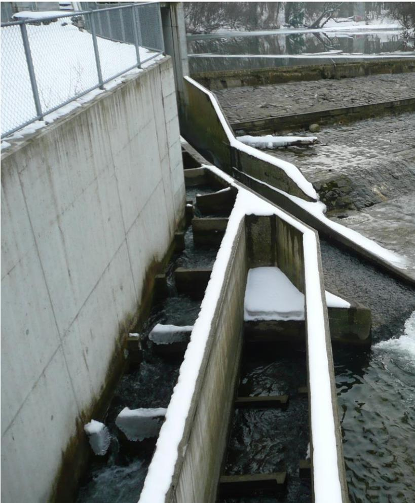
Abbildung 46: Die Zugänglichkeit zu den einzelnen Becken des Schlitzpasses ist durch hohe Mauern erschwert, die Zwischenmauern sind schmal und bei Schnee und Eis nicht begehbar. Die Arbeitssicherheit ist nicht gewährleistet.
