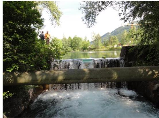
Abbildung 110: Abschlussperre des Kiesfanges mit Auslauf in den Vilterserbach
