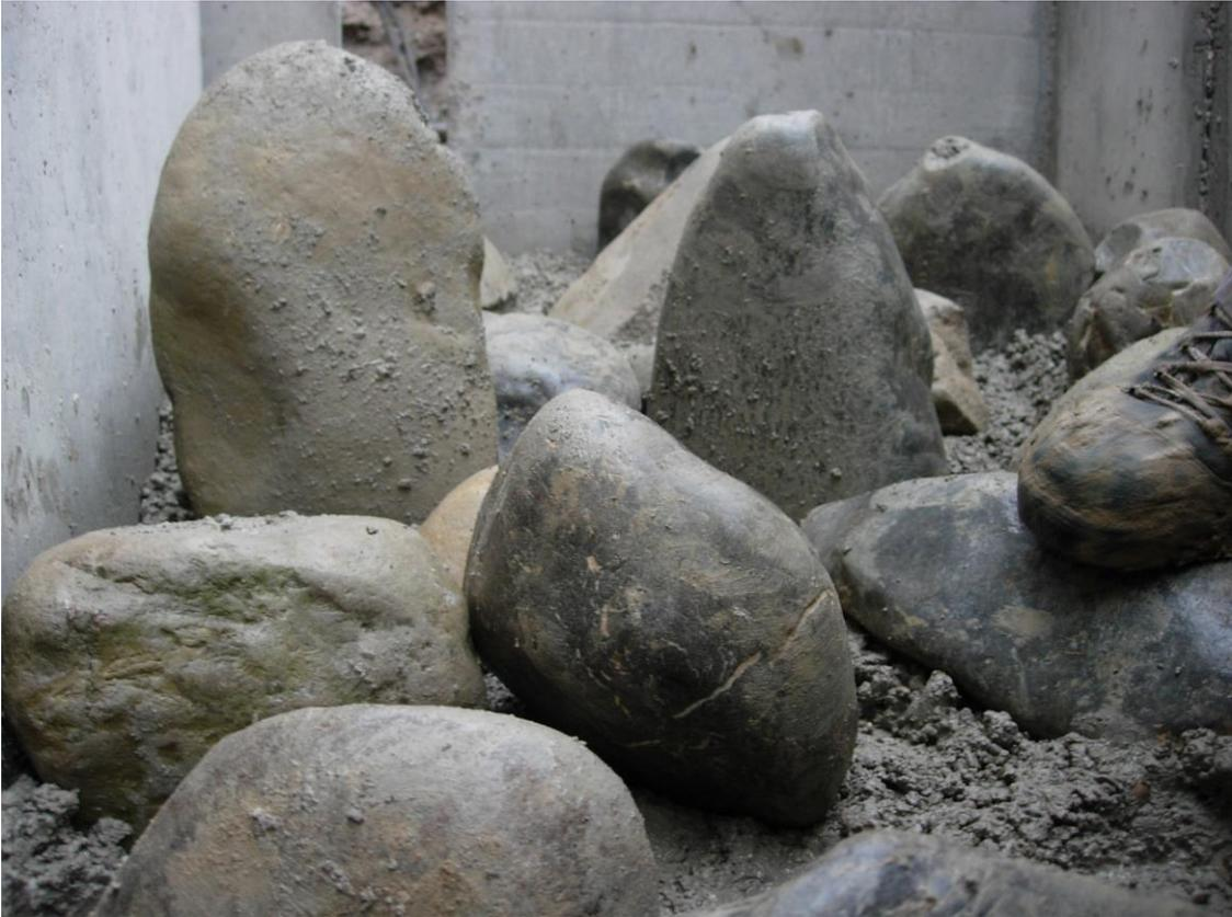
Abbildung 45: Musterstrecke für Sohlengestaltung im Schlitzpass (als Grössenvergleich der Schuh des Poliers).
