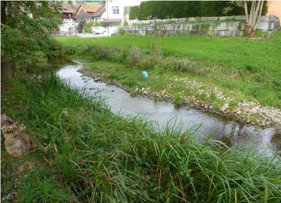
Abbildung 167: Anlage im Hauptschluss zum Wagnerbach in Eschenbach mit deutlicher Geschiebebank (Grobkies) an der Stauwurzel
