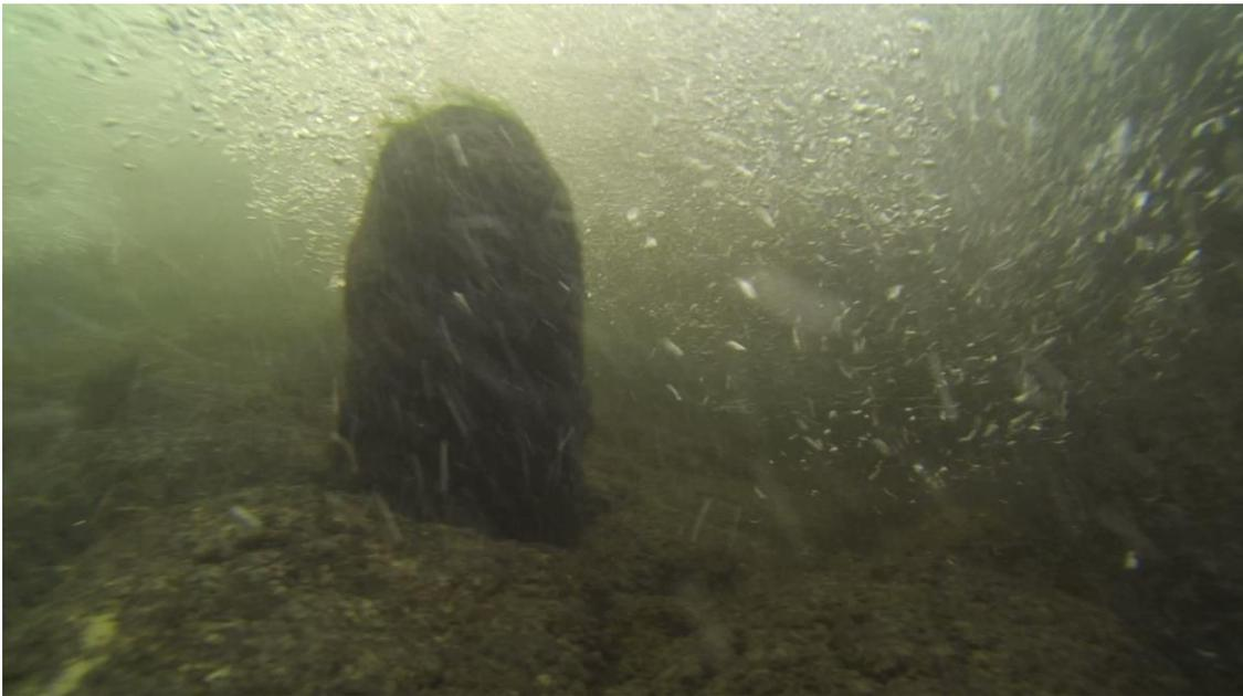
Abbildung 43: In den einzelnen Becken sind Störsteine eingebaut.
