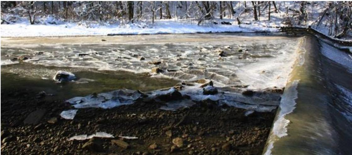
Abbildung 161: Stauwehr Erlenholz an der Sitter. Abgesenkter Stauspiegel beim Wehr Erlenholz vor dem Schwall
