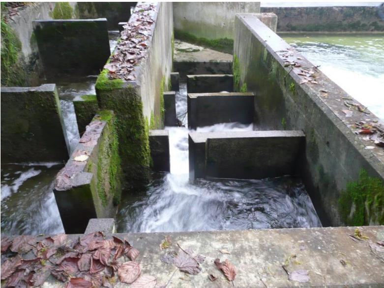
Abbildung 38: ungenügende Dotierwassermenge, unterschiedliche Schlitzbreiten und Gefälle
