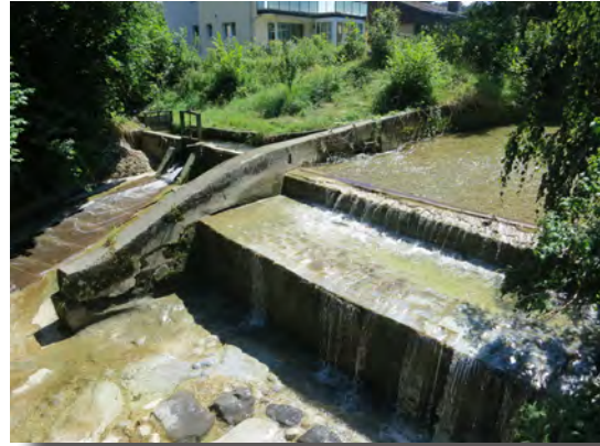
Abbildung 25: Seitenentnahme für den Oberwasserkanal der Ölmühle Briseck (43203).
