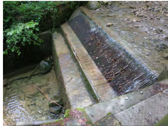
Abbildung 42: Tirolerwehr mit Schwelle bei der Wasserfassung der Lochmühle Malters im Kesselbach.
