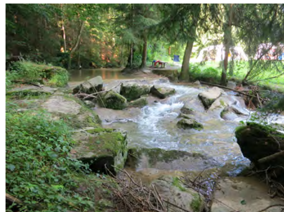
Abbildung 11: Aufgelöste Blockrampe bei der Seitenentnahme der Winonmühle (60001).
