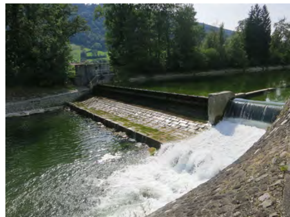
Abbildung 39: Wehranlage des Kraftwerks Thorenberg.
