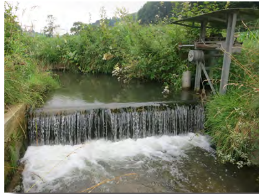
Abbildung 23: Absturz bei der Seitenentnahme des Kraftwerks Gläng im Rickenbach.
