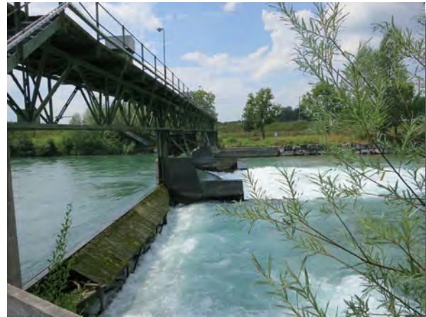
Abbildung 31: Wehranlage Perlen in der Reuss, seit 2005 ohne Fischaufstiegshilfe.
