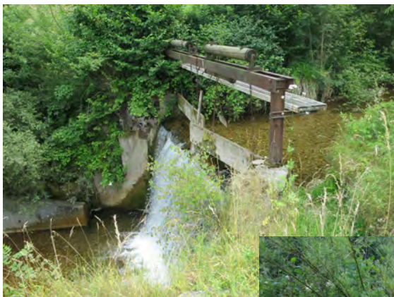
Abbildung 22: Absturz bei der Wasserfassung der Mühle Hergiswil in der Enziwigger (links), sowie eingesandeter Beckenpass 2014 (Mitte) und 2003 bei der Erstellung (rechts).
