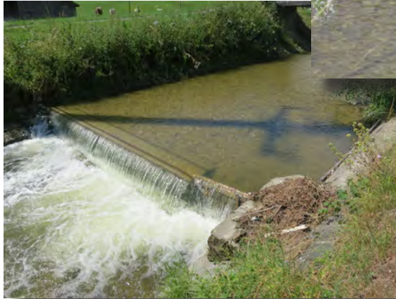
Abbildung 45: Schwelle bei der linksufrigen Wasserentnahme der Sägerei Unternährer (20009).
