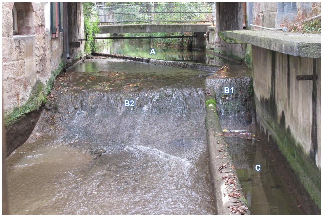
Foto 6: Zufluss über den Absturz B1 zum Bypass (C) bei Teichabschlag
