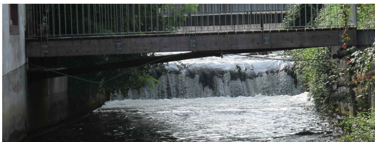
Foto 2: Absturz Wullenerb (mit Blick bachaufwärts)
