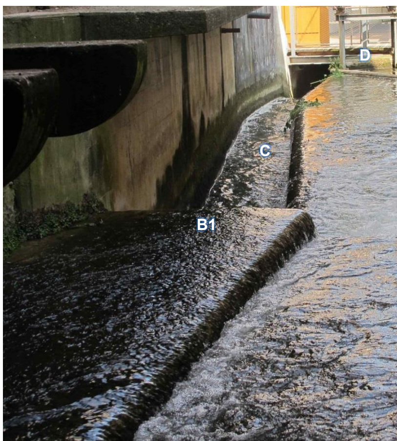
Foto 4: Zufluss über den Absturz B1 zum Bypass (C )
