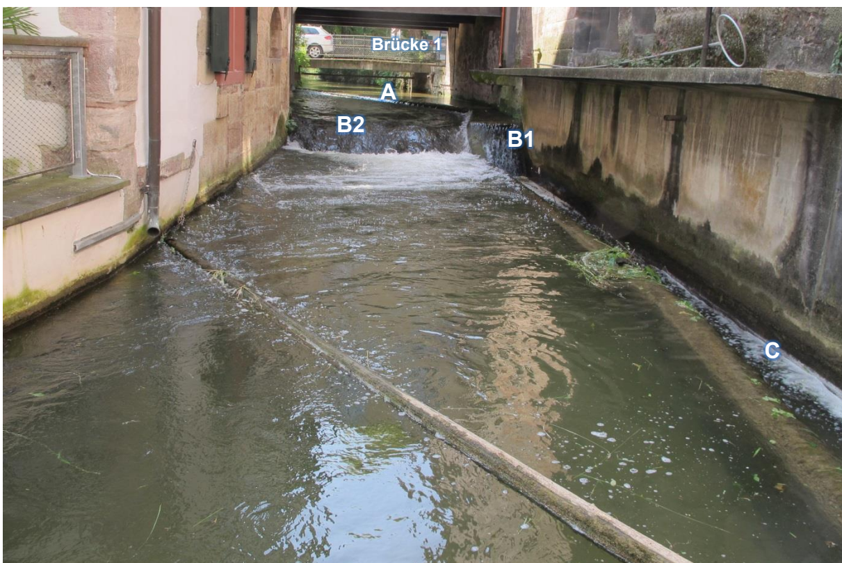
Foto 2: Blick von Brücke 2 flussaufwärts : (A) Diagonale Schwelle, (B) Absturz 1, (C) Bypass
