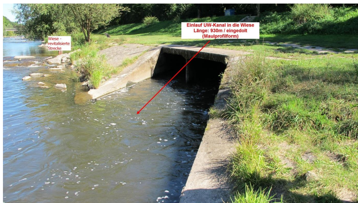
Foto 4: Einleitung des Unterwasserkanals in die revitalisierte Wiese
