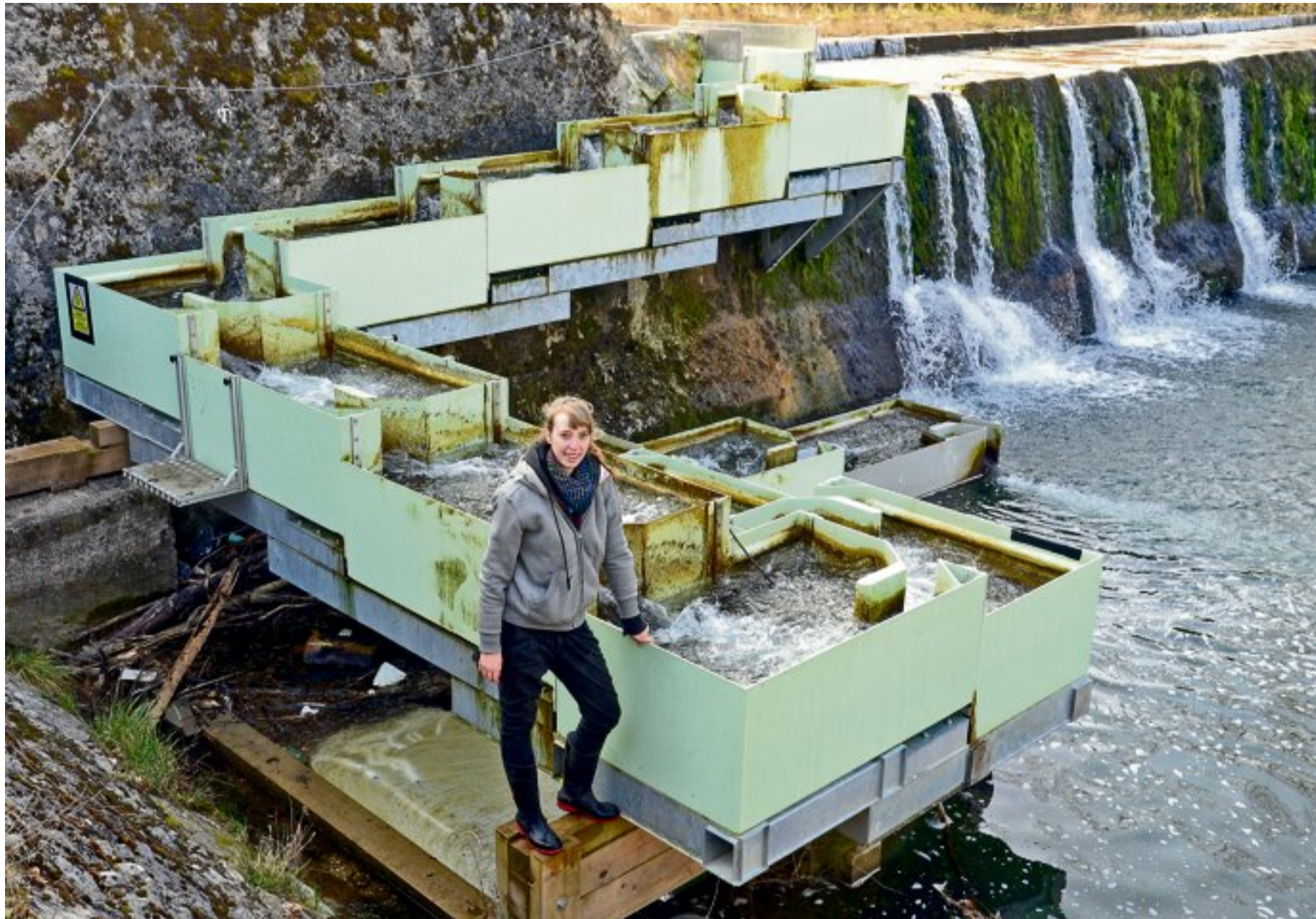
Über grüne Kunststoffmodule können Fische den künstlichen Wasserfall in der Töss wieder überwinden. Eva Baier will die Fischtreppe allerdings noch verbessern.
