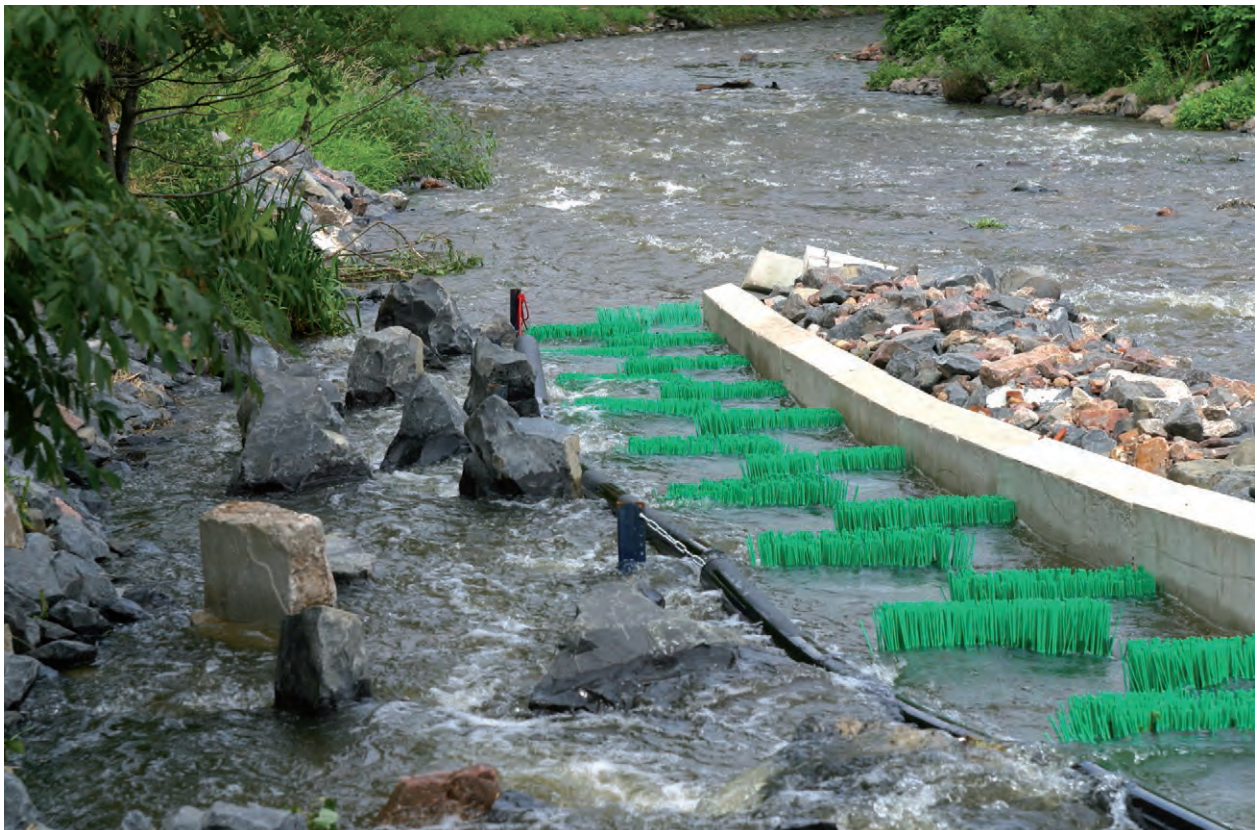
Abb. 47: „Two in one“: Zwei miteinander kombinierte Fischaufstiegsanlagen: Technischer Borstenpass (rechts) und parallel verlaufendes Raugerinne (links, noch im Bau befindlich)
