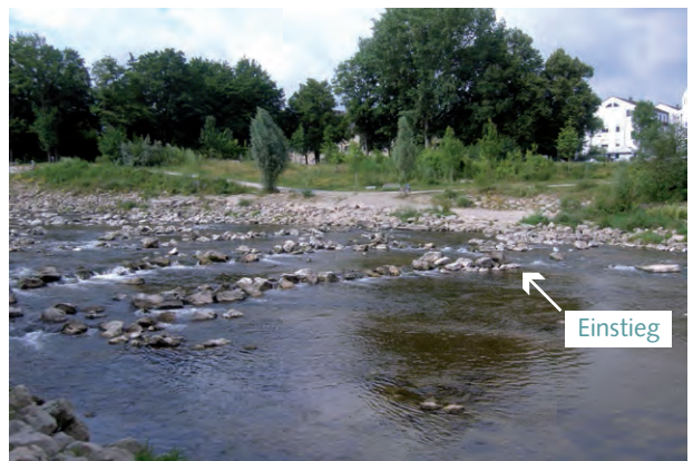
Übersicht Einstieg Sohlgleite und unterste Querriegel:
