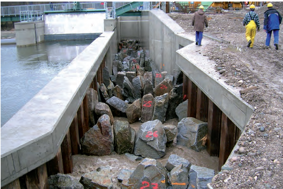
Abb. 48: Raugerinne-Beckenpass im Rohbau. In einem anschließenden Probelauf können Schwachstellen erkannt und nachgebessert werden.
