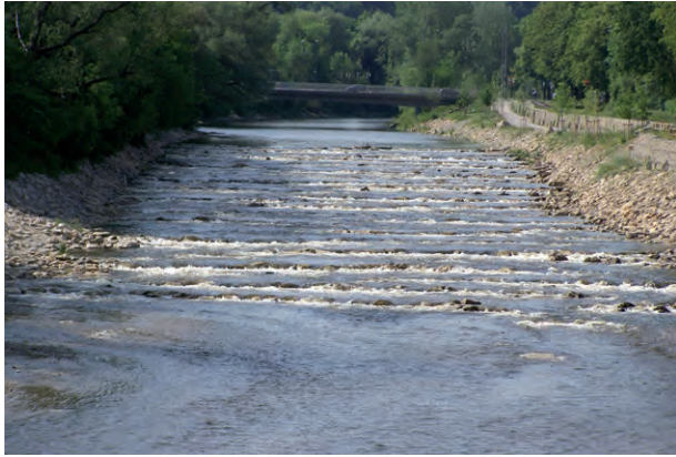
Übersicht Sohlgleite von unterstrom:
