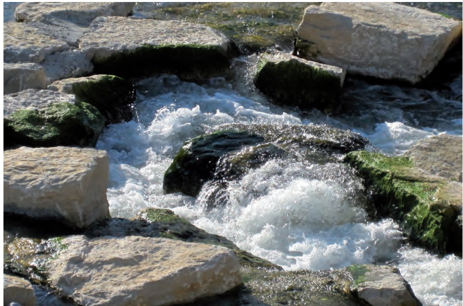
Abb. 14: Raugerinne (oben) unpassierbar, da hydraulisch überlastet und zu großes Gefälle (Bauj.2010); Raugerinne-Beckenpass (unten) gut passierbar, sehr gute Energieumwandlung, geringe Höhengsprünge (Baujahr 2007).
