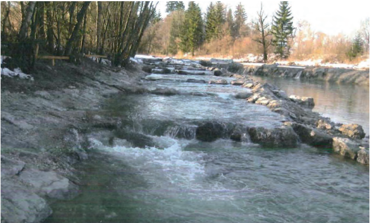
FAA-Neubau am Wehr Schönmühl, Becken mit Sohlswellen
