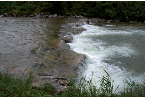
Detail Sohlschwelle (hohe Turbulenz, abgelöster Strahl):
