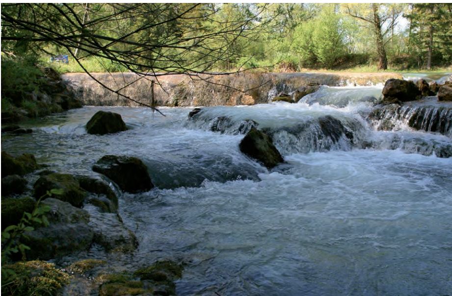
Abb. 15: Unpassierbarer Tümpelpass: Becken zu klein, Höhengsprünge zu groß, teilweise abgelöster Strahl, zu hohe Geschwindigkeiten, hydraulisch überlastet (Baujahr 1993).
