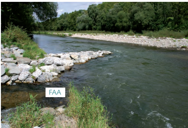
Einstieg FAA mit Leitbühne von oberstrom (~ MQ):
