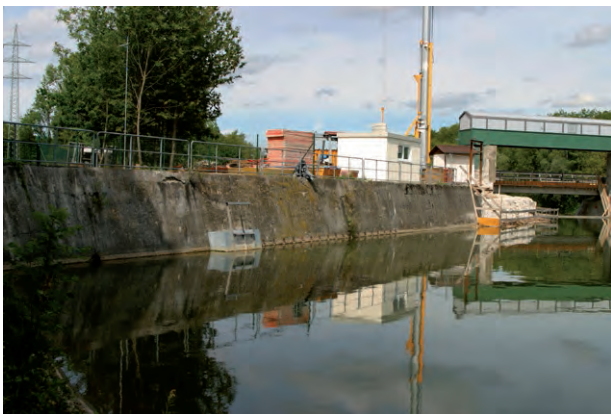
Anbindung (Metallkasten) der FAA ans Oberwasser:
