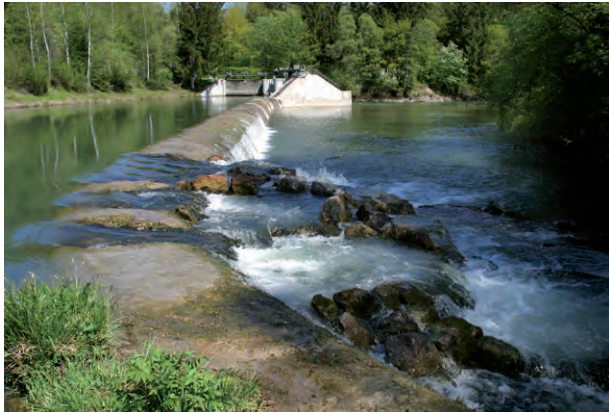
Übersicht FAA, Wehr von oberstrom:
