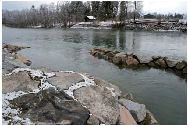
Einstieg FAA von oberstrom (~ MQ):
