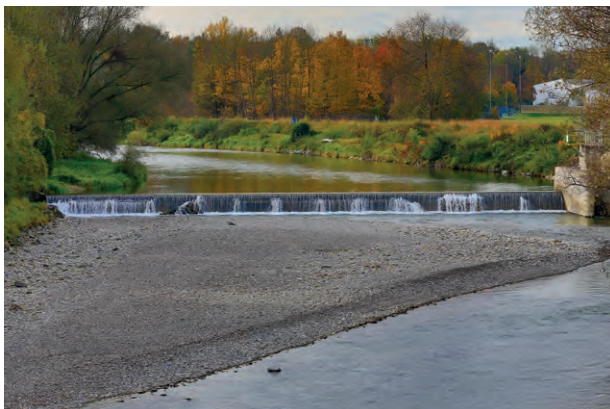
Abb. 31: Umbau eines Wehrs (Bild links) an der Alz bei Burgkirchen in eine zweigeteilte Sohlgleite (Bild rechts) mit Beckenstruktur und Blocksteinstruktur; dazwischen verläuft eine „Kanugasse“, Inbetriebnahme Juni 2015
