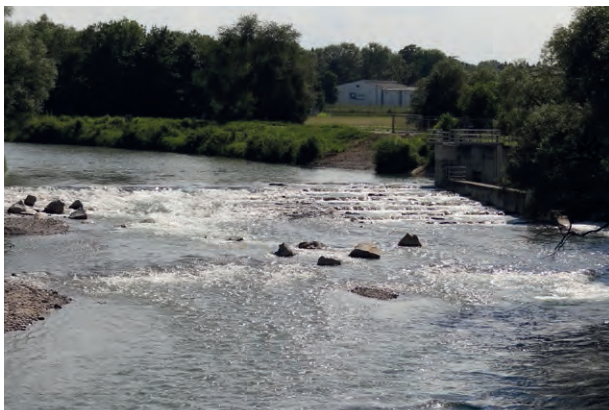
Gesamtanlage bei erhöhtem Abfluss (ca. Q 300)
