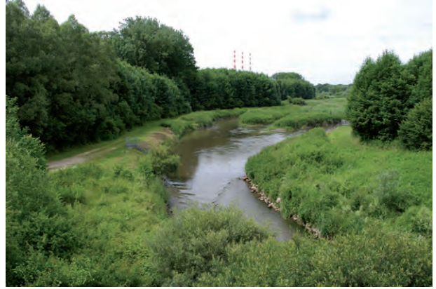
Übersicht UGS unterer Abschnitt: Befestigter Bereich mit Verzweigung (Inseln)
