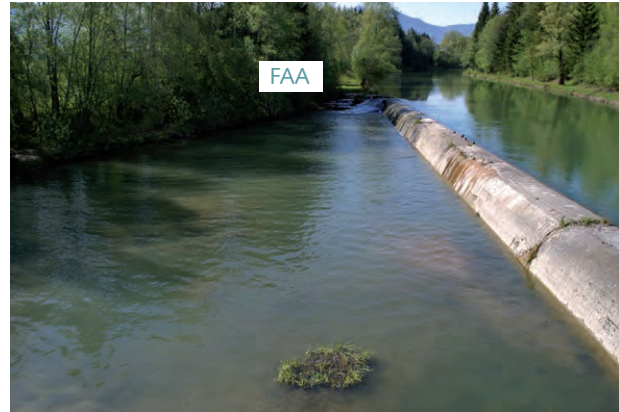
Strömungssituation unterhalb des Wehrs:
