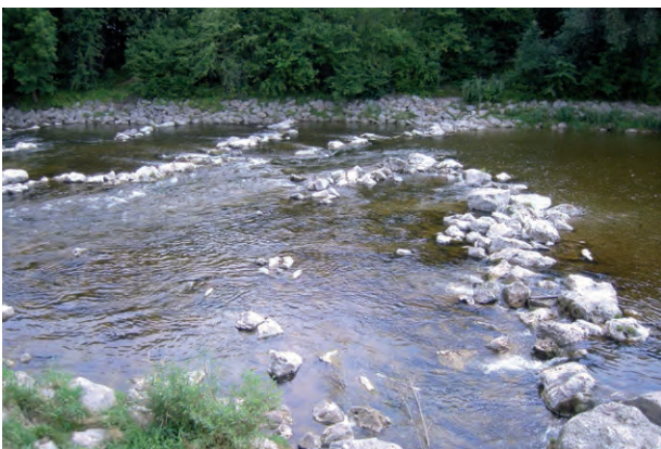
Anbindung Sohlgleite ans Oberwasser:
