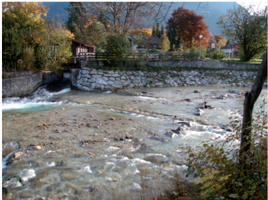
Abb. 28: Rückgebautes Wehr, Partnach, Garmisch-Partenkirchen.
