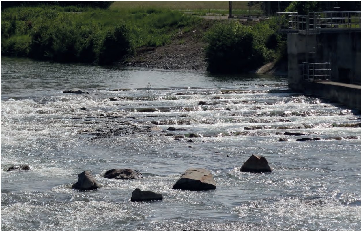
Beckenförmige FAA und Anschlussbereich der Blocksteingleite bei erhöhtem Abfluss (ca. Q\ 300 )
