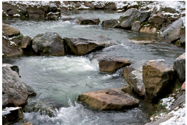
Detail FAA (obere Schwelle: abgelöster Strahl):
