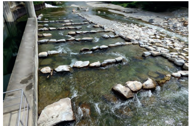
Beckenbereich der FAA (linke Flussseite) in Fließrichtung (ca. Q 30)
