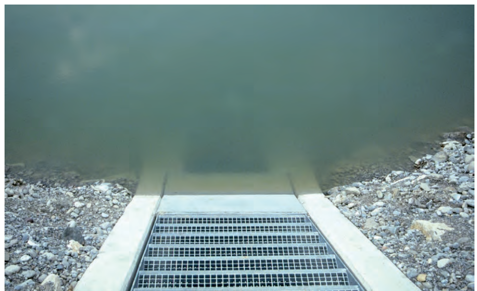
Abb. 26: Einlauf-/Ausstiegsbauwerk mit Tauchwand.
