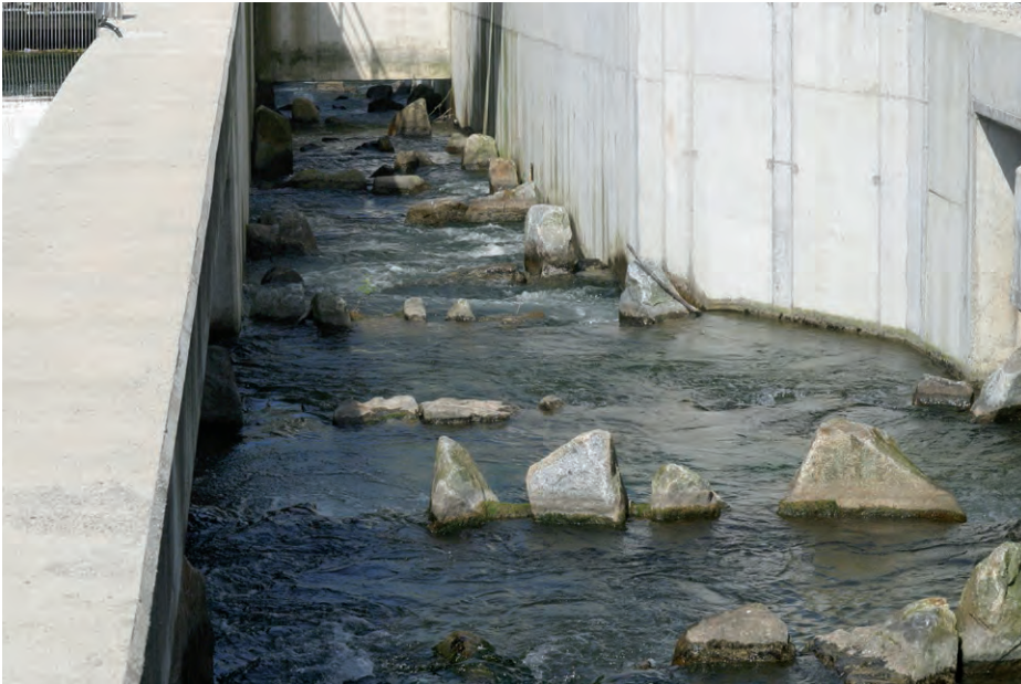
Abb. 46: Raugerinne-Beckenpass nach erstem Probetrieb (unten) und im Normalbetrieb (oben).
