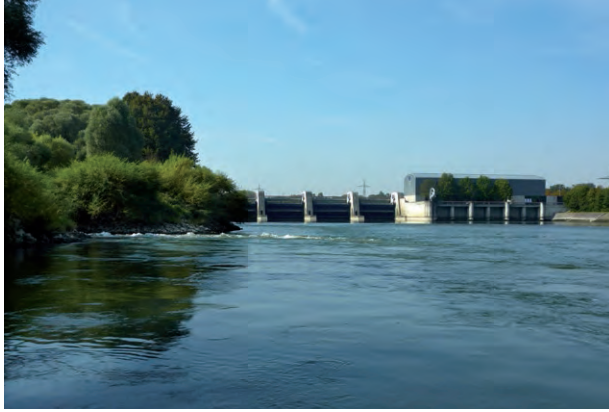
Übersicht Donaustufe Vohburg (Wehr, Kraftwerk und obere UGS-Mündung) von unterstrom:
