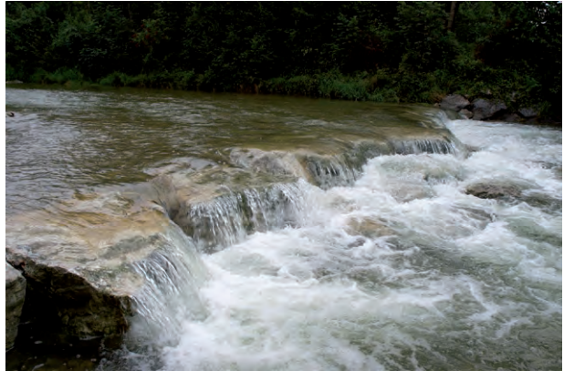
Detail Sohlschwelle (große Höhengsprünge, abgelöster Strahl, zu große Überfallhöhe):
