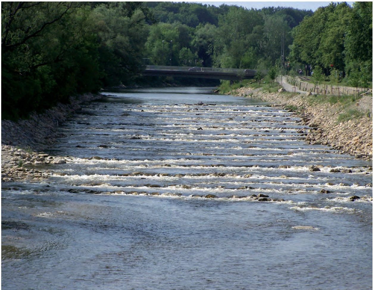
Abb. 9: Sohlgleite (ehemaliges Goggeleswehr) an der Wertach: auf gesamter Flussbreite auffindbar.
