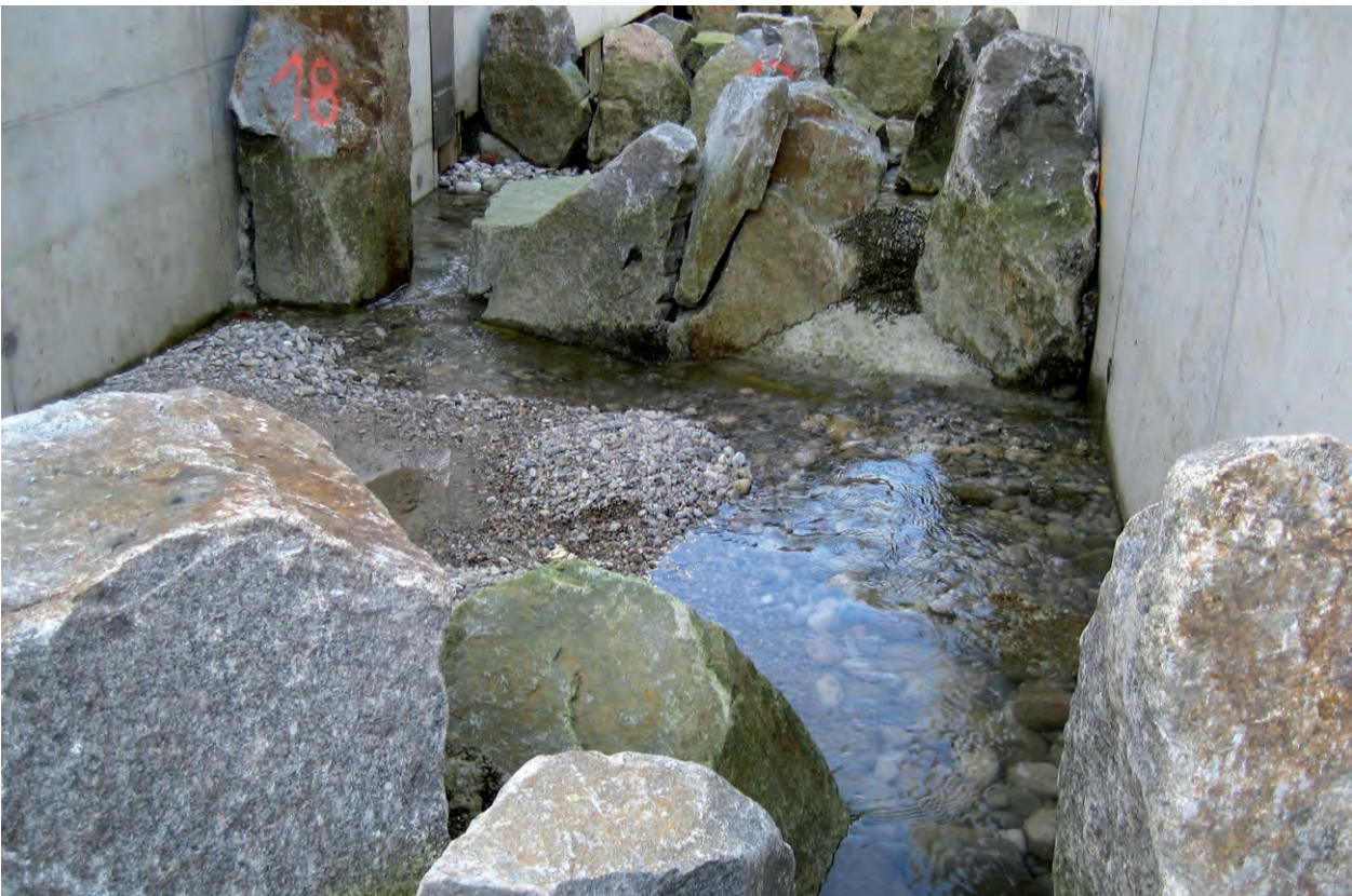
Abb. 46: Raugerinne-Beckenpass nach erstem Probetrieb (unten) und im Normalbetrieb (oben).
