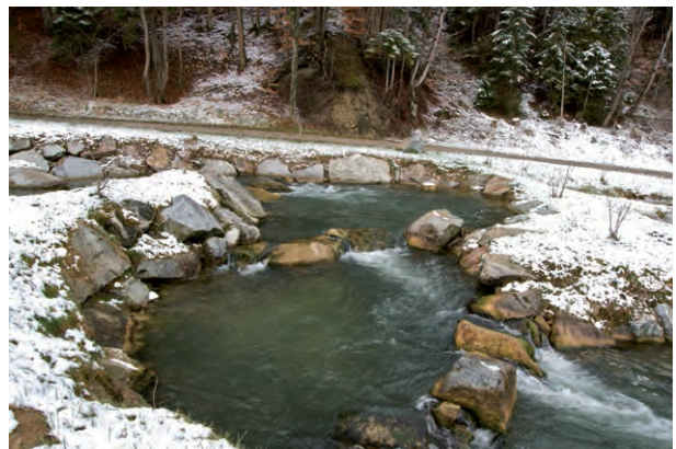
Detail FAA (lange Engstelle mit großen Höhengsprüngen):
