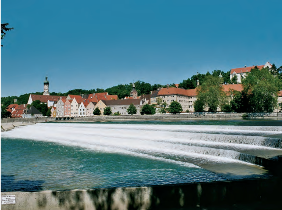
Abb. 8: Karolinenwehr, Landsberg am Lech; oben: Weißwasserzone (Turbulenzbereich), unten: Einstiege der FAA (blaue Pfeile) unmittelbar flussabwärts der Turbulenzzone (Bezugsabfluss MQ).
