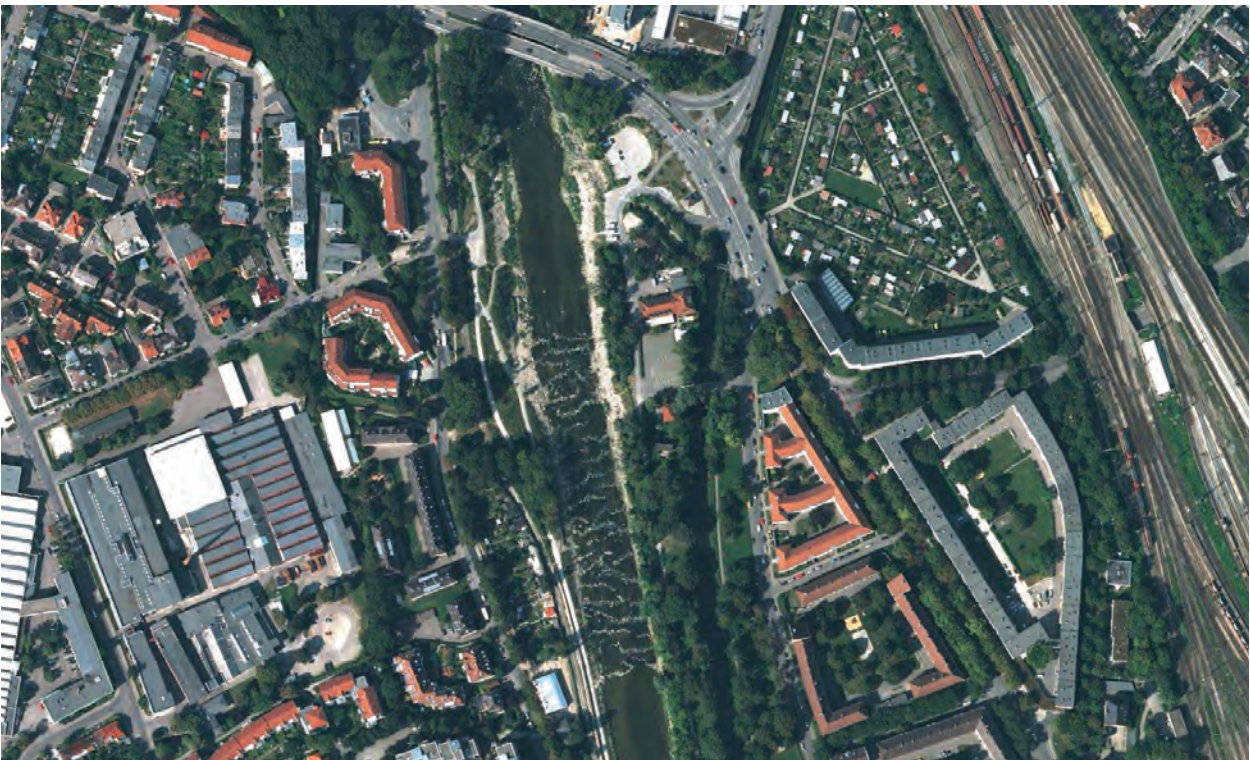
Übersicht Lage nach Rückbau des Wehrs:
