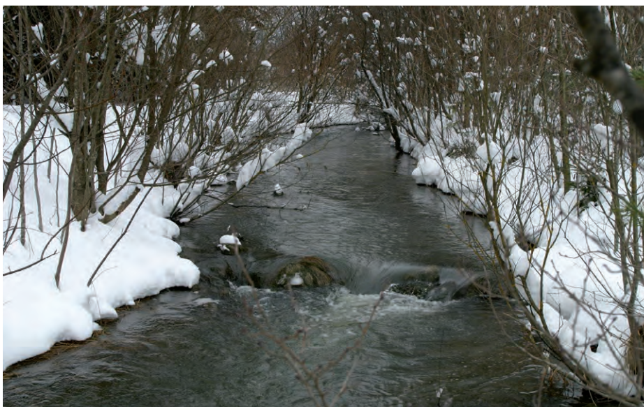
Abb. 22: Gut passierbare Schwelle mit kurzem Übergang, kompaktem Strahl und ausreichendem Wasserpolster.
