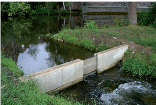
Anbindung FAA ans Oberwasser:
