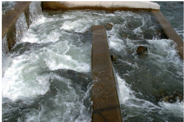
Detail FAA 2 (~ 2/3 MQ; hohe Turbulenzen):
