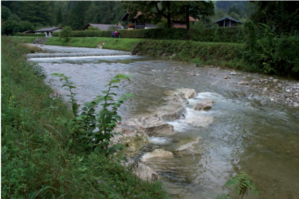
Detail Sohlschwelle (hohe Turbulenz, abgelöster Strahl):
