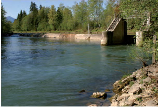
Übersicht FAA und Wehr von unterstrom:
