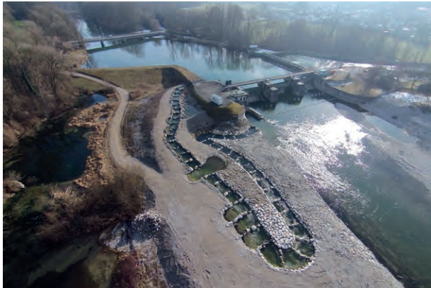
Abb. 42a) 42b): Tümpelpass am Alz-Wehr Tacherting mit großzügiger geometrischer Dimensionierung und sehr moderaten hydraulischen Bedingungen, größenbestimmende Zielart: Huchen (Inbetriebnahme 2014).
