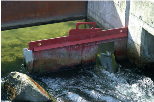
Abb. 24: Regulierbarer Einlauf-/Ausstiegsschlitz mit vorgelagerter Tauchwand (links), rechts: Kontrollreue für Aufstiegs- und Abstiegskontrollen.
