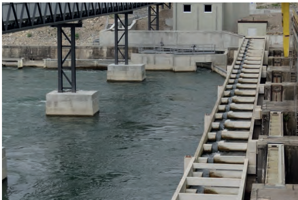
Abb. 27 links: Überleitungs- Schlitzpass vom Trennpfeiler (FAA Mündungen 3 u. 4) zum rechten Ufer. Im Hintergrund FAA Mündung 2 über dem Sogschlauch, Rechts: FAA-Mündung 1 mit Überleitungs-Schlitzpass und Beginn des Umgebungs-bachs (Raugerinne-Beckenpass)
