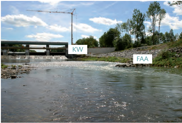
Übersicht Wehr, Kraftwerk und FAA von unterstrom (~ MQ):
