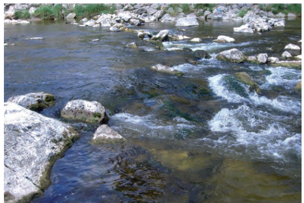
Detail Querriegel mit Übergang der Niedrigwasserrinne:
