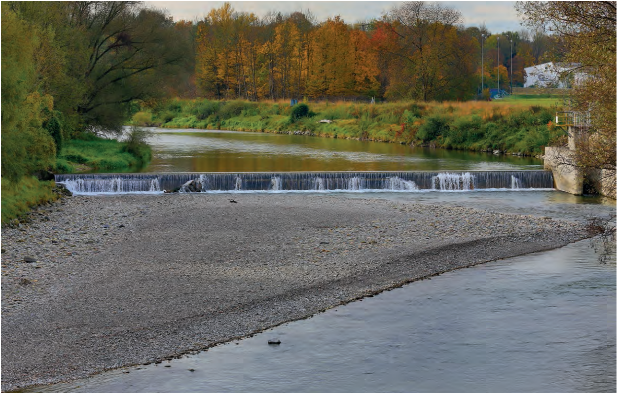
Übersicht Wehr vor Umbau von unterstrom:
