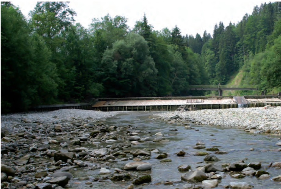
Abb. 13: Ausleitungsstrecke mit zu wenig Mindestwasser und zu geringen Wassertiefen: für größere Fische unpassierbar.
