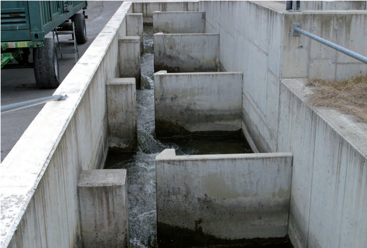
Abb. 19: Schlitzpass mit sehr günstigen hydraulischen und geometrischen Eigenschaften, gute Strahlumlenkung ausreichende Energiedissipation in den Becken.
