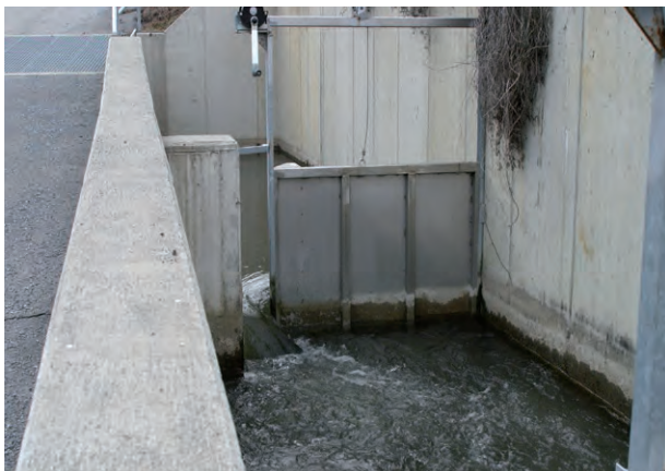
Abb. 10: Schlitzpass (links) mit verstellbaren Trennwänden/ Schlitzöffnungen in den oberen Beckenreihen zur Dotationsregulierung und Anpassung an schwankende Unterwasserstände. Teilrampe (rechts) mit guter seitlicher (blauer Pfeil) Einstiegsmöglichkeit für Fische – auch bei erhöhten Unterwasserständen gut auffindbar.
