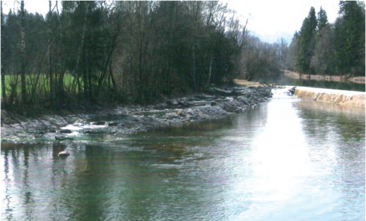
FAA-Neubau am Wehr Schönmühl, Becken mit Sohlswellen
