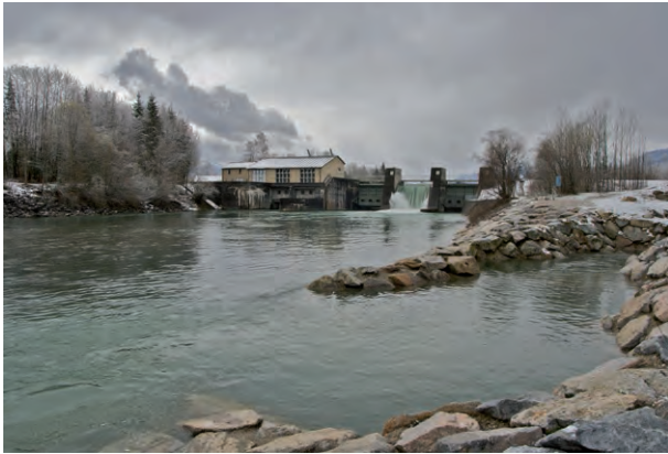
Übersicht Kraftwerk, FAA, Wehr von unterstrom (~ MQ):
