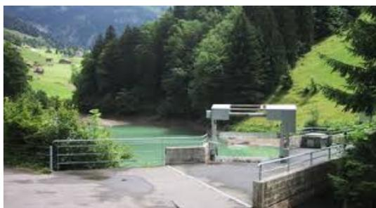
Die Stauhaltung Käppelistutz (nutzbares Volumen ca. 60'000 m<sup>3</sup>) nutzt einen bestehenden Taleinschnitt (Eingangs Wolfsschlucht) und wird talseitig mit einer künstlichen Talsperre (Höhe 18m) abgegrenzt. Die Positionierung des Speichersees im Gerinne verhindert apriori die Geschiebeführung, was sich insbesondere in der Verlandung des Zuflussbereichs und der Stauhaltung manifestiert.
