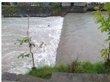
Das Kraftwerk Ambauenwehr bezieht das Wasser direkt aus der Engelberger Aa und leitet dieses via Sagikanal/Giessen zum Vierwaldstättersee. Die Wasserentnahme wird durch eine hydromechanisch gesteuerte Wehrklappe bewerkstelligt, welche sich bei entsprechenden Hochwasserabflüssen selbstständig ablegt. Im Betriebskonzept ist, im Interesse des Anlagenbetreibers, eine Ausschaltung des Kraftwerksbetriebs bei beginnendem Geschiebetrieb in der Engelberger Aa (ca. 40m<sup>3</sup>/s) vorgesehen.
