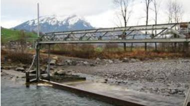
Das Kraftwerk Hostetten bezieht das Wasser direkt aus der Engelberger Aa und leitet dieses via Kanal zum Kraftwerk, wo es nach der Turbinierung wieder der Engelberger Aa zugeführt wird. Die Wasserentnahme wird im Teilquerschnitt durch ein mechanisch gesteuertes Tauchwehr bewerkstelligt, welches bei entsprechenden Hochwasserabflüssen gezogen wird.
