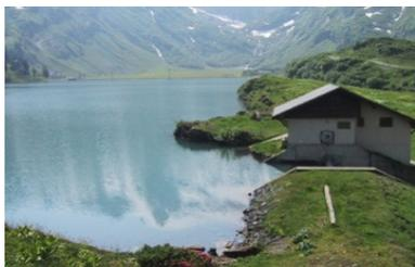
Der Trüebsee (0,3 km<sup>2</sup>; 650'000 m<sup>3</sup>; 9m Tiefe<sub>max</sub>) nutzt eine bestehende Geländekammer und wird talseitig mit einem Erdamm abgegrenzt. Die Positionierung des Speichersees im Gerinne verhindert die Geschiebeführung vollständig, was sich insbesondere in der Verlandung des Zuflussbereichs manifestiert. Entsprechend beginnt nach dem Speichersee das sedimentologische Einzugsgebiet neu. Hochwasserwellen hingegen werden leicht gedämpft in den Unterlauf weitergeleitet.
