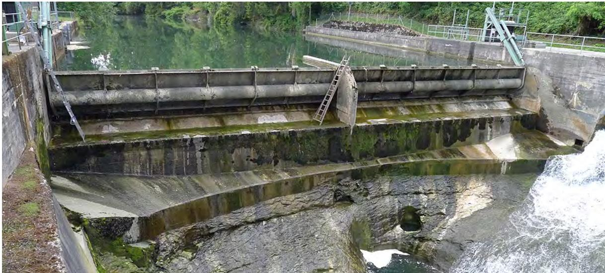
*Bild 22* Blick birsaufwärts auf die Wehranlage der Kraftwerke Büttenen I+II mit zwei Wehrklappen und den links und rechtsseitig angeordneten Ausleitkanälen.
