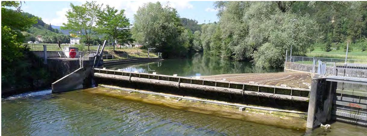
Bild 16 Blick birsaufwärts auf die Wehranlage des Kraftwerks Obermatt mit Fischaufstieg (links), Wehrklappe (Mitte) und Geschiebeabzug (rechts).
