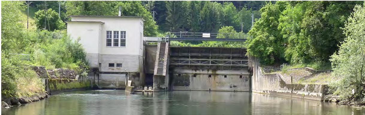
*Bild 18* Blick birsaufwärts auf die Wehranlage des Kraftwerks Moos mit Zentrale (links), Grundablass (Mitte) und Wehrfeld (rechts).
