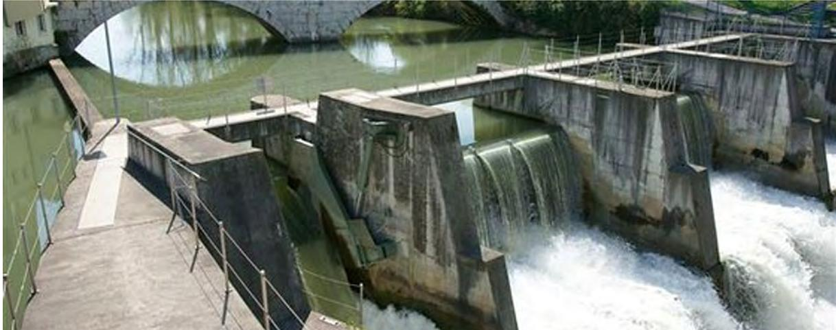
*Bild 24* Blick birsaufwärts auf die Wehranlage des Kraftwerks Dornachbrugg mit drei Wehrklappen (rechts), den Geschiebeabzug mit anhebbaarem Segmentschütz und dem kurzen Ausleitkanal (links).
