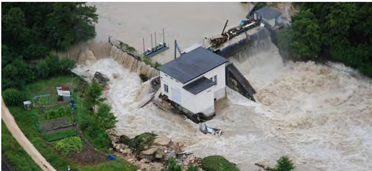
**Bild 9** Kraftwerk Moos während des Hochwassers von 2007. Verklauungen am Wehr führten zu Ausuferungen flussaufwärts des Wehres (Bild: [www.baselland.ch](http://www.baselland.ch), 31.07.2014).
