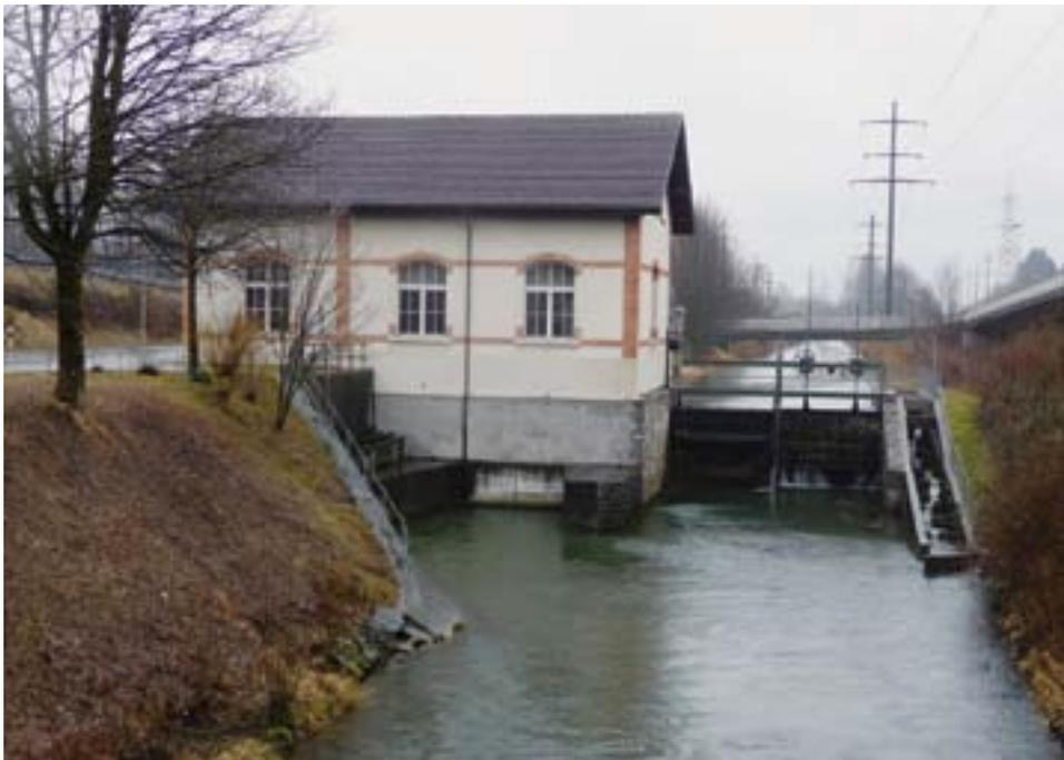
Abb. 8: Die Aufwanderung schwimmstarker Fische ins Oberwasser wird hier durch die Fischtreppe (Beckenpass) ermöglicht. Abwandernde Fische sind aber nicht in der Lage, die Fischtreppe zu finden. Abwanderungshilfen bei Kraftwerksanlagen fehlen in der Schweiz. Im Bild ein Kleinwasserkraftwerk am Rheintaler Binnenkanal (Kraftwerk Blatten bei Oberriet SG) (Foto: Armin Peter).
