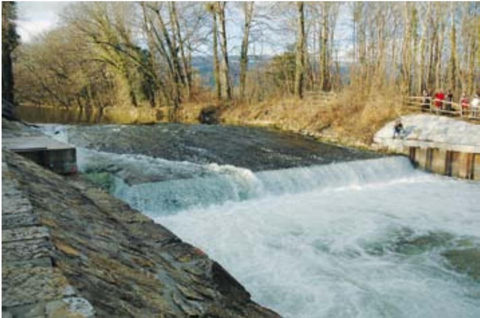
Abb. 3: Fragmentierter Lebensraum: Die Areuse im Kanton Neuenburg. Sprungstarke Fische (z. B. Seeforelle) vermögen die Höhe des Überfalls zwar zu überspringen, werden dann jedoch auf der steilen Rampe durch die hohen Fliessgeschwindigkeiten abgetrieben (Foto: Armin Peter).
