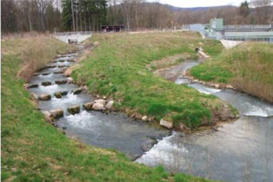
Abb. 9: Umgehungsgerinne an der Aare bei Schönenwerd. Die naturnahe Gestaltung ermöglicht allen aufwandernden Fischarten, in den Staubereich oberhalb des Wehres zu gelangen. Die Länge des Umgehungsgerinnes beträgt 170 Meter (Foto: Armin Peter).
