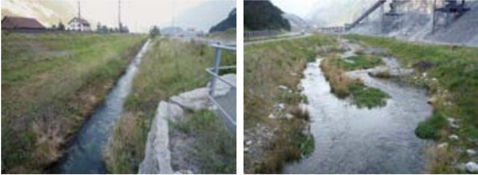
Abb. 12: Der kanalisierte (links) und revitalisierte (rechts) Walenbrunnen bei Schattdorf (UR) (Fotos: Christiane Rau).
