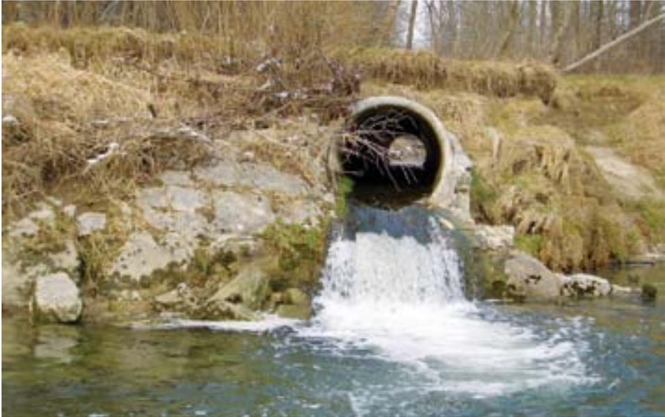
Abb. 4: Abgekoppeltes und verrohrtes Seitengewässer an der Thur bei Flaach (ZH). Der in die Thur einmündende Seitenbach ist isoliert. Der Überfall und die Verrohrung verhindern einen Austausch von Organismen von der Thur in den Seitenbach (Foto: Armin Peter).
